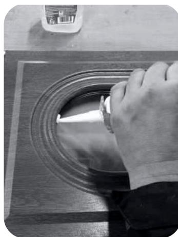
Applicare uno strato sottile di silicone polimerico
