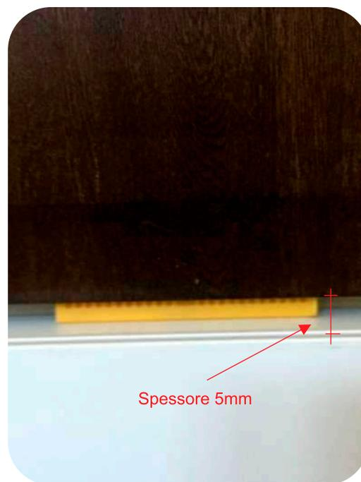
Particolare dello spessore ai fini dello Smaltimento della Condensa
