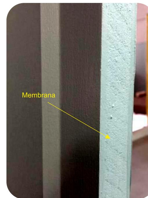
Particolare della finitura con la Membrana Elastica Impermeabilizzante
